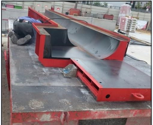
**Soudure de fourrures métalliques sur banches appartenant au chantier**
