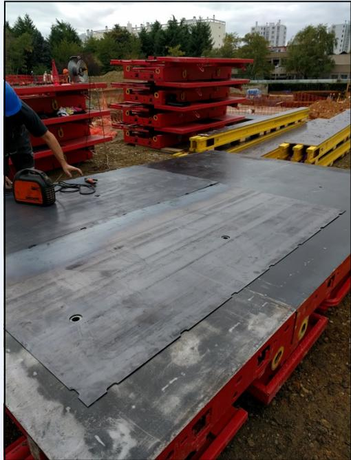
**Soudure de platines en sous-face**
